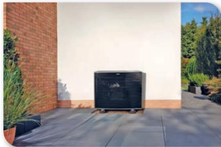
matización. Esta tecnología, utiliza la energía térmica contenida en el aire y lo transforma en calefacción, agua caliente sanitaria y aire acondicionado en verano. La unidad exterior, también conocida como bomba de calor, es la encargada de captar el aire exterior y transferirla a un fluido refrigerante que la transforma en frío o calor en función de las necesidades del clima, transmitiéndola por el interior del hogar gracias a las unidades interiores.
