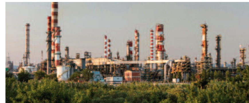
Complejo industrial de Repsol en Tarragona
